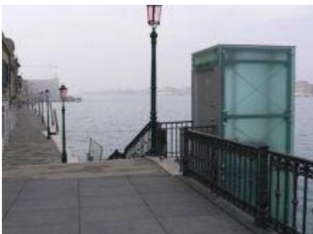
**L'elevatore** è formato da due piattaforme elevatrici "protette" poste all'inizio e alla fine di un ponte.
