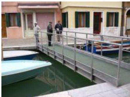
**La passerella a raso** è sicuramente più comoda e accessibile ma di fatto impedisce il traffico delle imbarcazioni. Ne sono state realizzate due, in forma provvisoria, sul Rio della Crea a Cannaregio e nel centro dell'isola di Burano.
