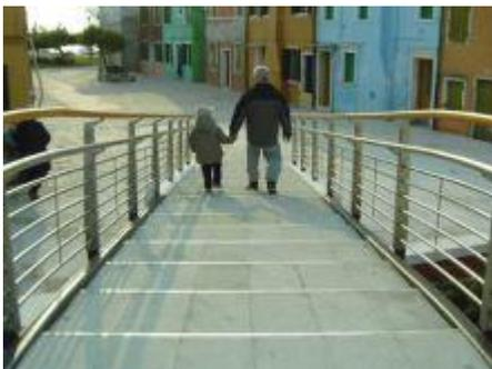
**Il gradino agevolato** viene utilizzato solo nei casi in cui le pedate del ponte siano sufficientemente profonde creando una rampa con gradini ad alzata ridotta e con angolo smussato, che permette alla persona in carrozzina con accompagnatore di superare agevolmente il ponte.
